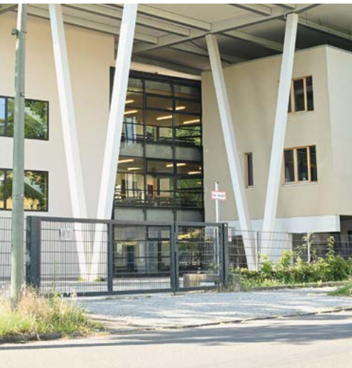
Das Dach der Athene-Grundschule lastet nicht auf dem Gebäude, sondern auf V-förmigen Stützen, die in Stahlverbundbauweise errichtet wurden.
